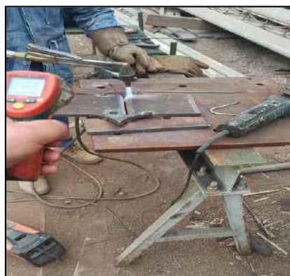
Fig. 2 Medición de temperatura de precalentamiento con el pirómetro.
