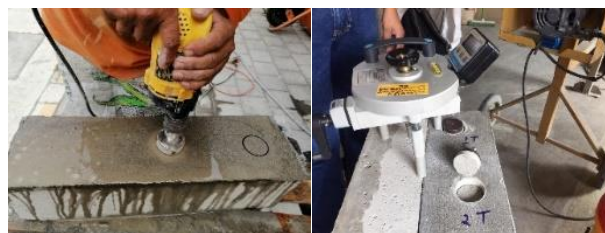
Fig. 2 Ensayos de adherencia – Equipo utilizado
