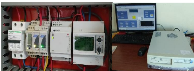
Fig. 3. Conjunto instrumental de control módulo Eos-Array y PC de adquisición de datos.
