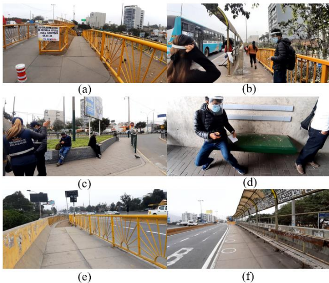
Fig. 1. (a) Zona aledaña al paradero sur obstaculizada y con espacios inaccesibles. (b) Dimensión de una rampa de acceso. (c) Zona de espera en el paradero este con mobiliario inadecuado. (d) Bancas de espera sin cumplir requerimientos mínimos. (e) Espacios sin utilizar (f) Estado actual de un paradero.
