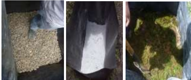
Fig. 3. Colocando grava, cal y la materia orgánica a los sistemas de tratamiento
